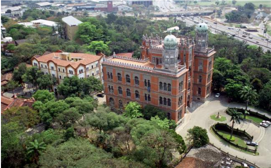
Figura 1 – Vista aérea do Núcleo Arquitetônico Histórico de Manguinhos.
