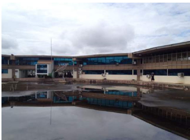
Figura 2 - Vista interna do espelho d'água da Prefeitura de Caracará, projeto do Arq. Sergio Bernardes.
