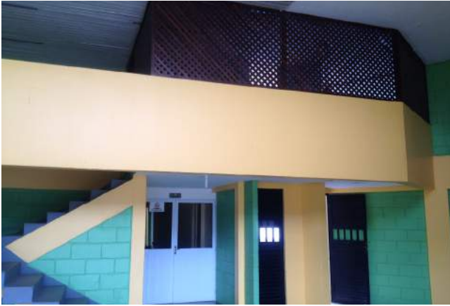
Figura 3 - Vista interna do prédio da Prefeitura de Caracaraí, projeto do Arq. Sergio Bernardes.
