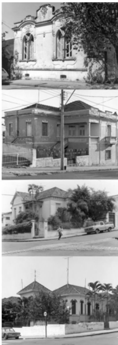
De cima para baixo: Rua São Joaquim 1545 (demolida); Rua Treze de maio 1702 (restaurada, em uso); Rua Episcopal 1347 (demolida); Rua José Bonifácio 700 (conservada, em uso). Fonte: acervo da autora, 1985-1986.
