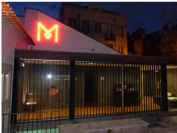
Figura 03 - Centro de Inovação da Mouraria. Imagem que mostra um dos acessos ao pátio e às salas do subsolo do CIM, bem como o espaço de acesso ao local que funciona como galeria de exposições.
